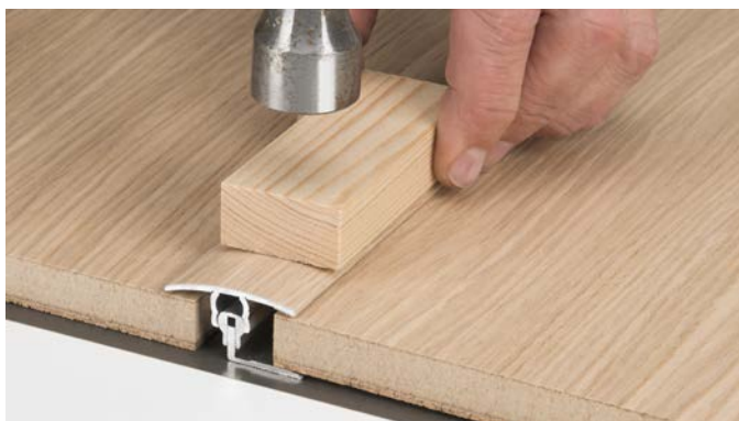
Instalace přechodového profilu hliníkového
